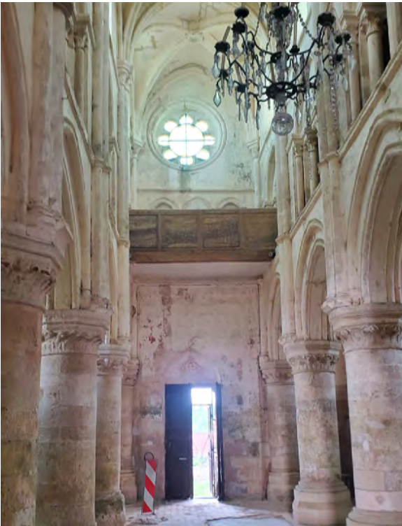
Vue de l'élévation intérieure Ouest.
