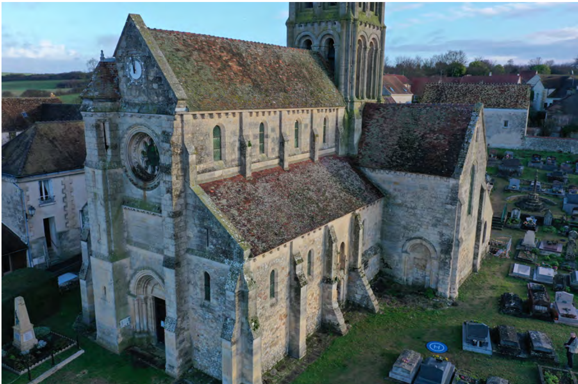
Vue aérienne de l'église côté Ouest.
