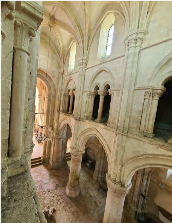
Vue en partie de la nef côté Sud-Est.
