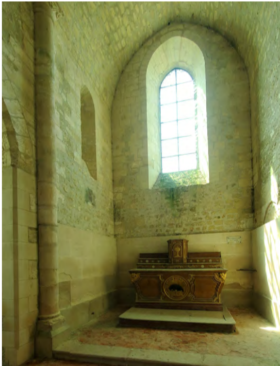
Vue du bras de transept intérieur Nord.
