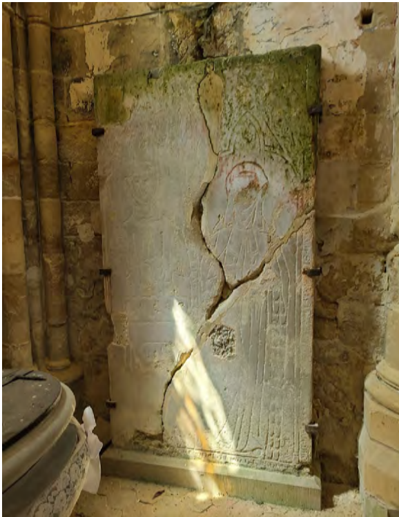
Fissures sur table sculptée.
