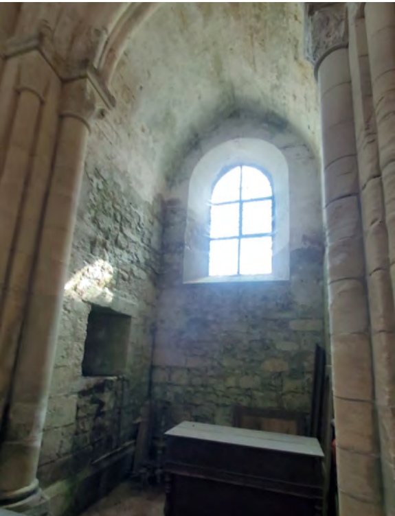
Vue intérieure du corps-bas Nord.
